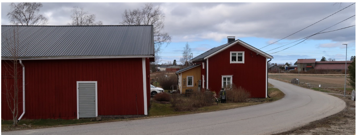
Figur 28. Vy från Stationsvägen mot väster. Vägen svänger ner mellan gårdarna mot åkrarna och vidare till stationen.
