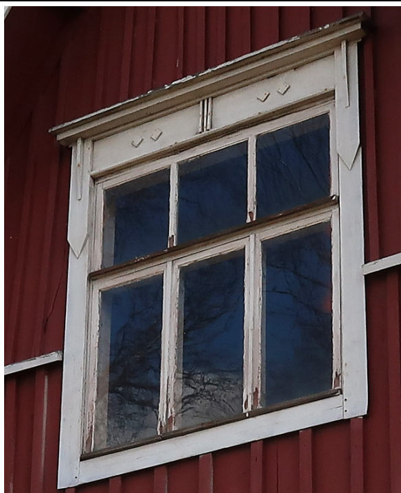
Ikkuna länsisivun poikkipäädyssä.
