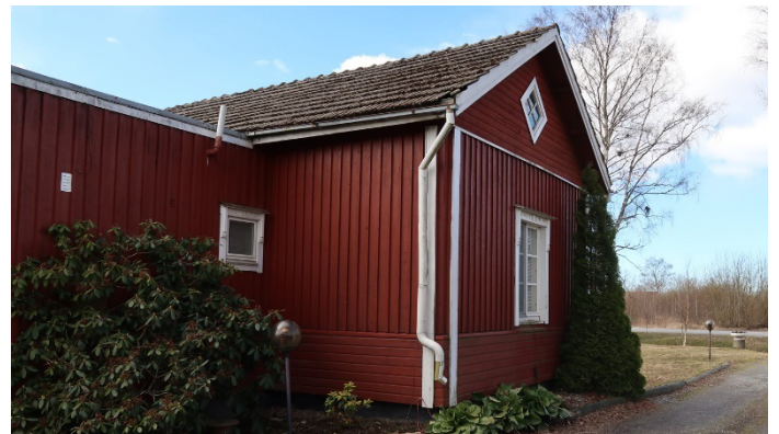
Pohjoispuolen pääty ja laajennuksen liitoskohta.
