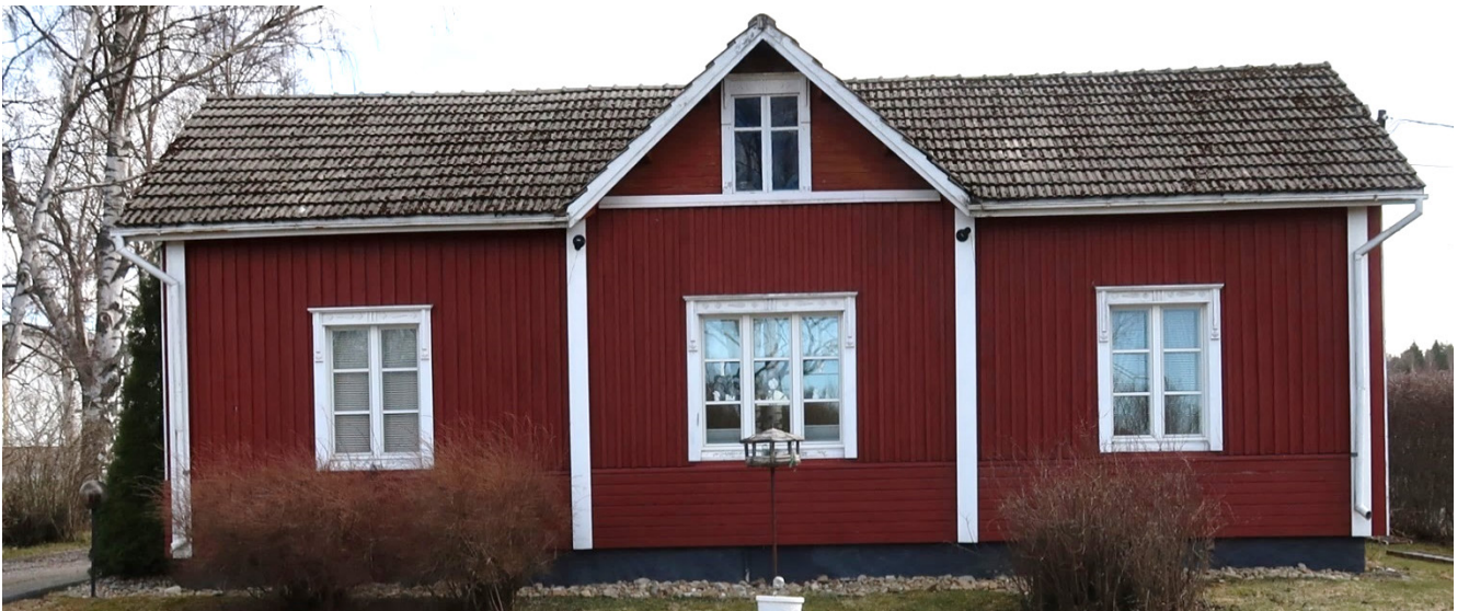
Julkisivu Asemapihan tielle päin länsi-luoteeseen.
