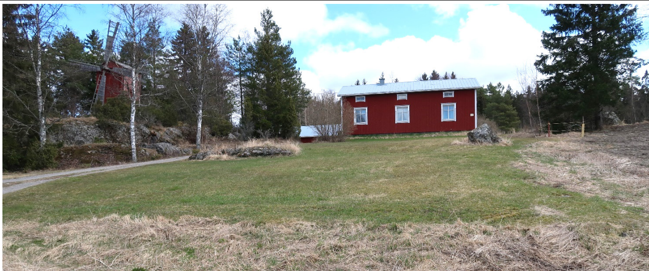
Pihapiiri on rinteän yläosassa. Rakennusten pohjoispuolella on kalliolla tuulimylly.
