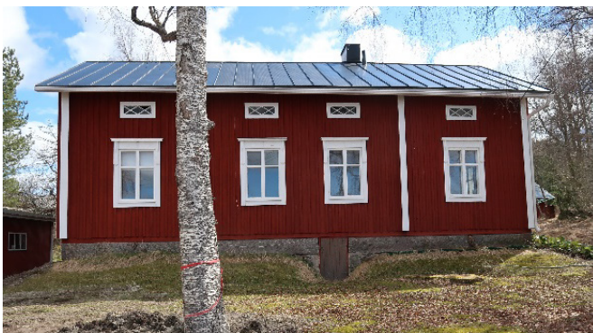
Julkisivu länteen Itäpellontien suuntaan.
