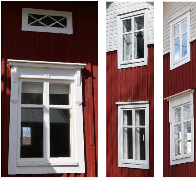
Kaksijakoisissa ikkunoissa on koristeellisempia ja yksinkertaisempia vuorilaudoituksia. Vinoneliöpienaisen ullakkoikkunan vuorilaudoitus on yksinkertainen.
