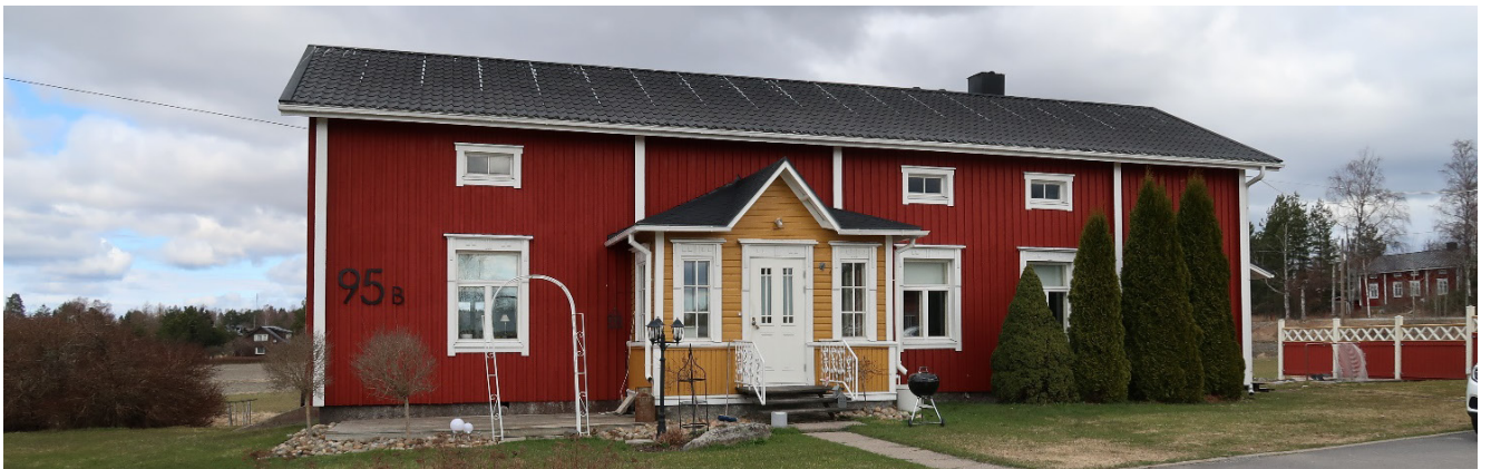
Julkisivu etelään Asematien suuntaan.
