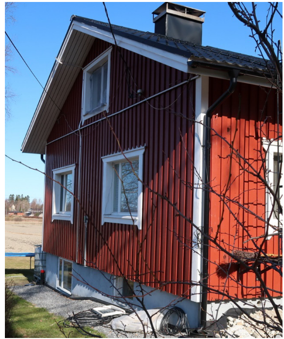
Rakennus on hiljattain remontoitu ulkoapäin.
