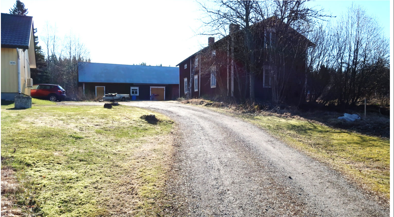
Näkymä pihatieltä itään. Pihapiiri sijoittuu rinteen laelle. Vasemmalla uuden asuinrakennuksen pääty, taustalla pitkä piharakennus, oikealla vanha asuinrakennus.
