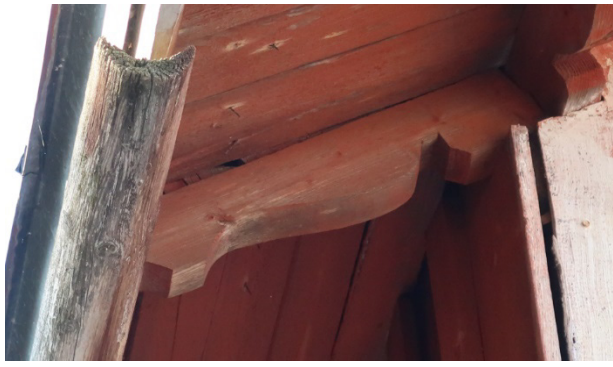
Puinen räystäskouru ja koristeelliset kattotuolinpääät.
