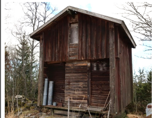
Hirsirakenteinen puuverhoiltu aitta.
