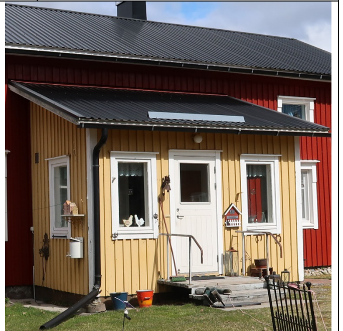
Kuistissa on yksiruutuiset ikkunat ja uusi ovi.
