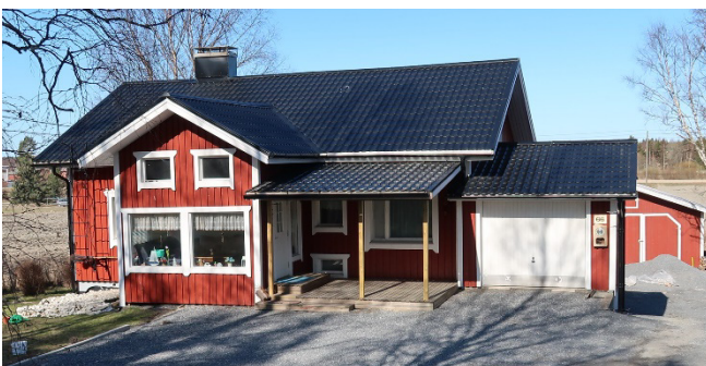
Julkisivu itään Itäpellontien suuntaan.
