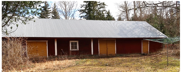
Pihan itäosassa pitkässä piharakennuksessa on hirsipinnalla olevia osia, lautaverhoiltuja osia. Ovet ovat yhtenäisesti keltaokraa ja vuorilaudoitukset ja väliseinähsien päät ovat valkoisia.
