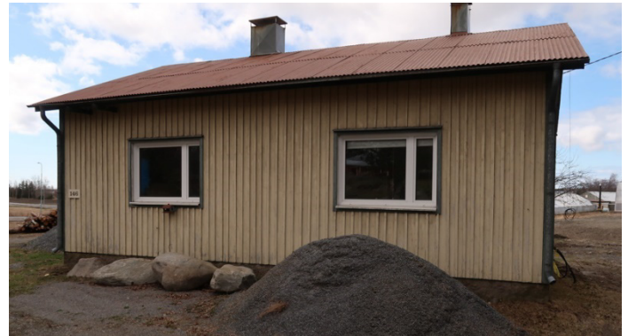
Julkisivu itään Itäpellontien suuntaan.
