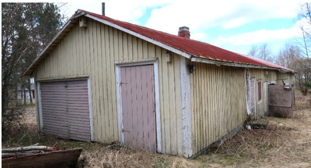
Piharakennuksen pääty Itäpellontien suuntaan.
