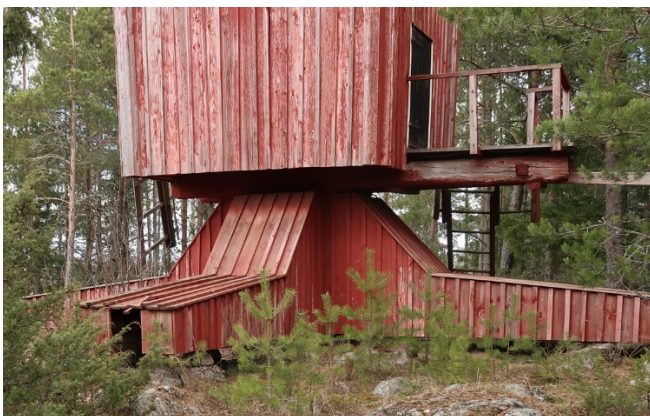
Yksityiskohdat tuulimyllyn jalasta ja alaosasta.
