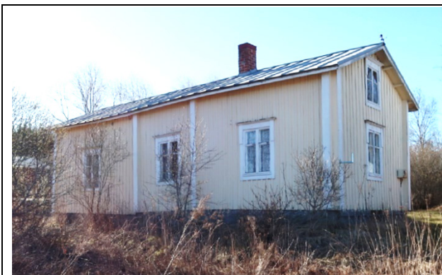
Julkisivu Teuvantien suuntaan pohjoiseen.
