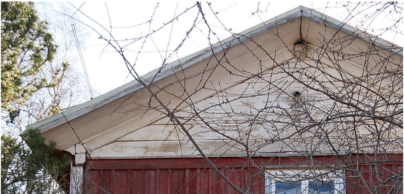
Räystäslaudoitus ja lista ovat profiloituja.
