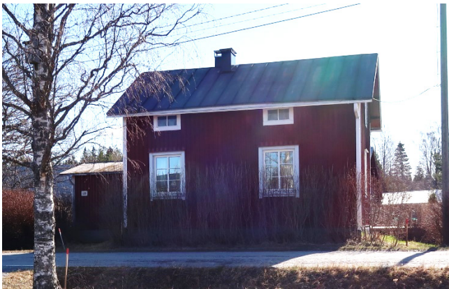
Julkisivu länteen Itäpellontien suuntaan
