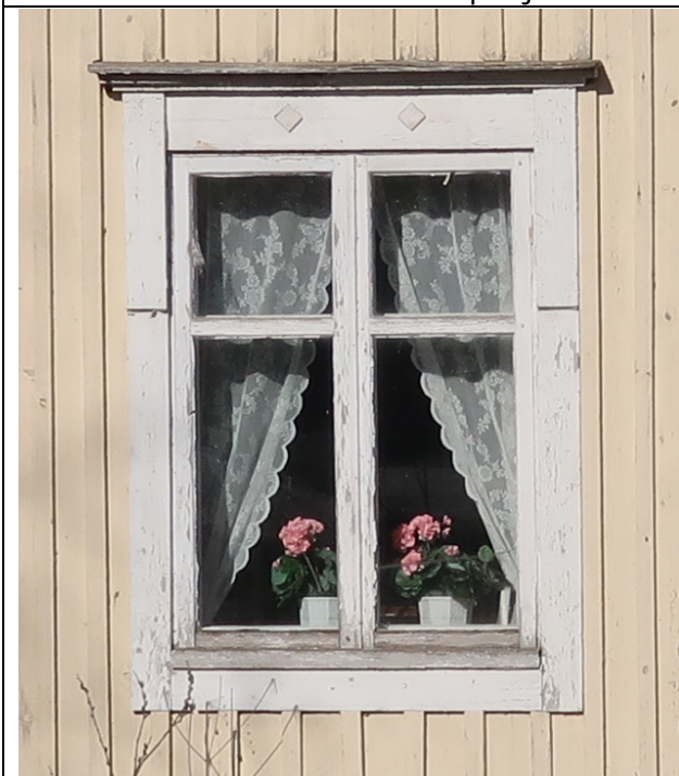
Kaksijakoisissa neliruutuisissa ikkunoissa on talonpoikaisklassiset vuorilaudat.
