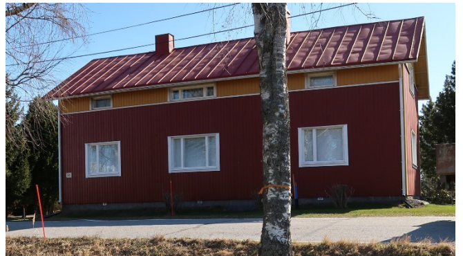
Julkisivu länteen Itäpellontien suuntaan.
