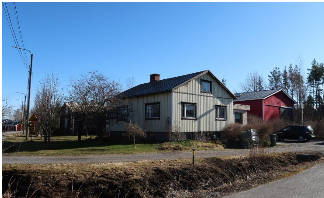
Uudempi asuinrakennus lounaasta
