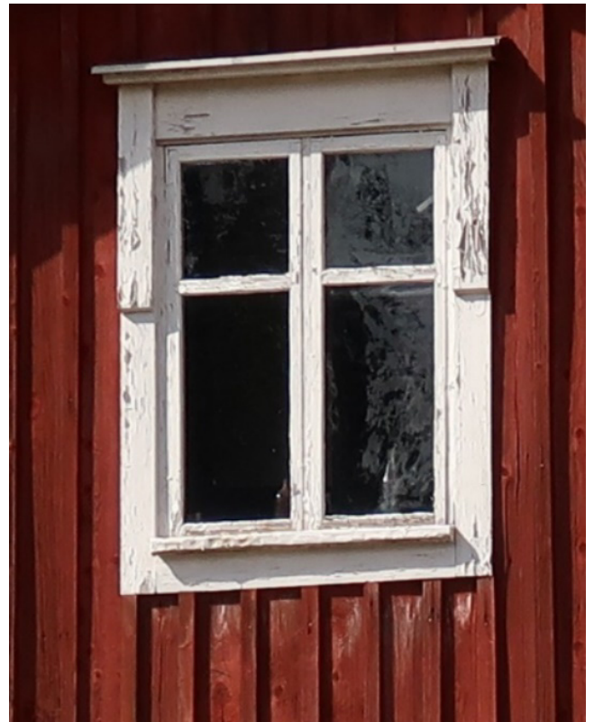
Ensimmäisen kerroksen ikkunoiden vuorilaudoituksen malli.
