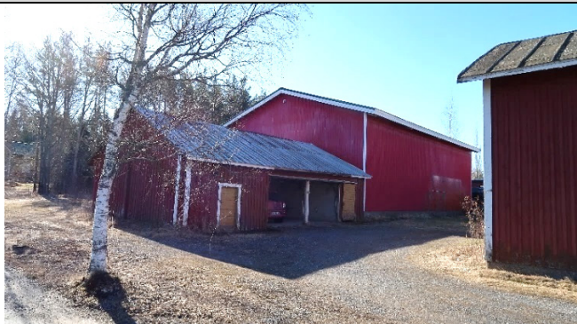
Uudempi eri kiinteistöllä sijaitseva piharakennus on rakennettu kiinni vanhaan piharakennukseen.
