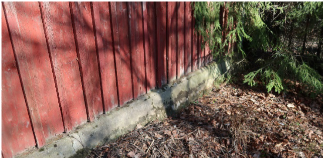
Kivijalka on vuorattu betonilla.
