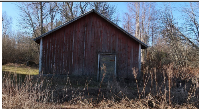
Piharakennuksen pääty pohjoiseen
