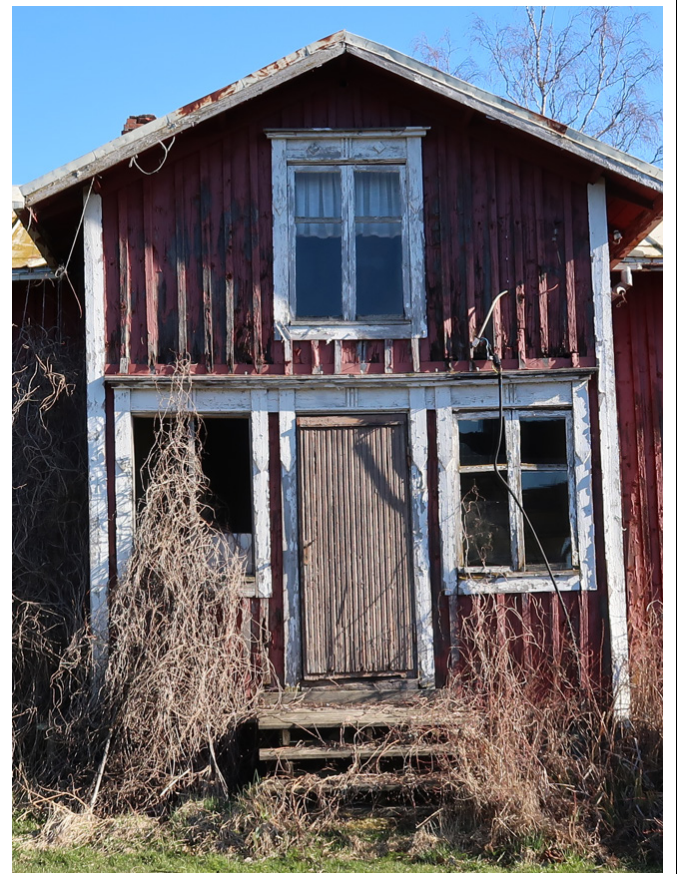
Täyskorkeassa kuistissa on yhtenäinen ikkunoiden ja oven kamanan vuorilaudoitus.
