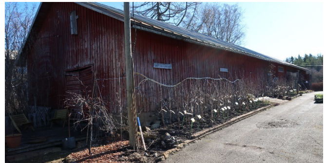
Kivinavetassa on lautaverhoiltu länsipääty, ylhäällä pohjoispuolelta ja alhaalla lounaasta.
