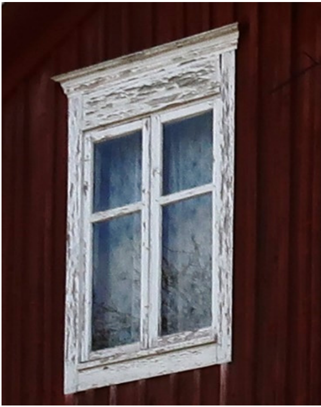
Ikkuna länsipäädystä, vanhan mallinen vuorilaudoituus.
