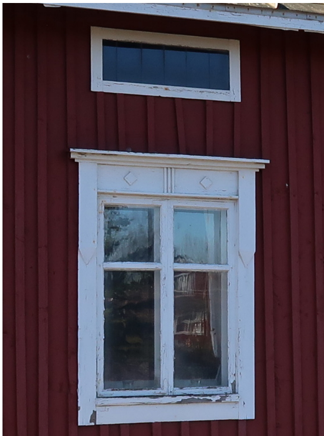
Kaksijakoisissa neliruutuisissa ikkunoissa on talonpoikaisklassiset vuorilaudat.
