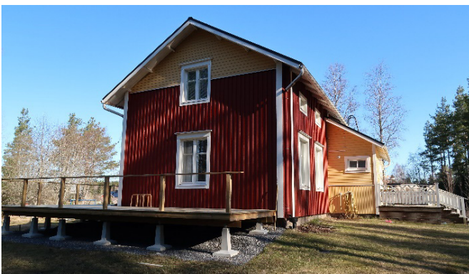
Pääty etelään. Terassi on rakenteilla
