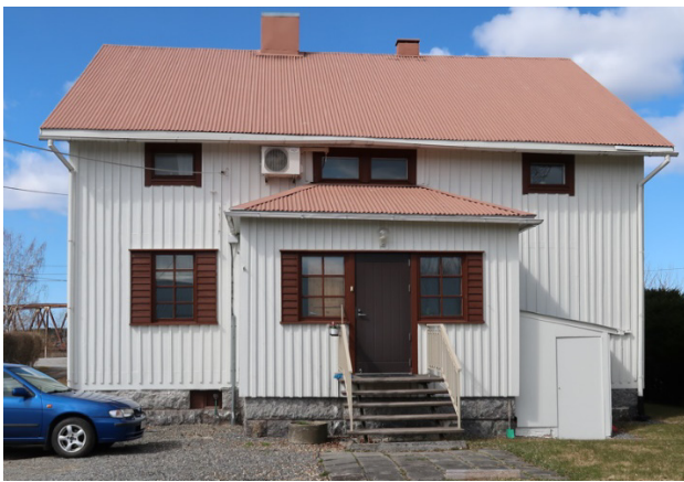
Fasad mot sydost.
