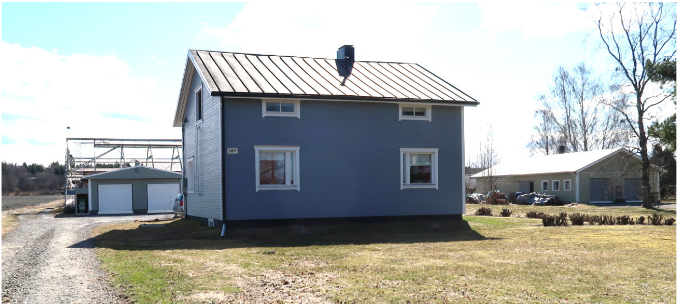
Fasade mot Kristinestadsvägen i väster.
