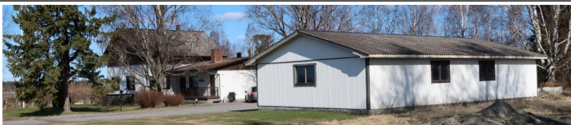
Gårdsbyggnad i östra delen av gårdsplanen.
