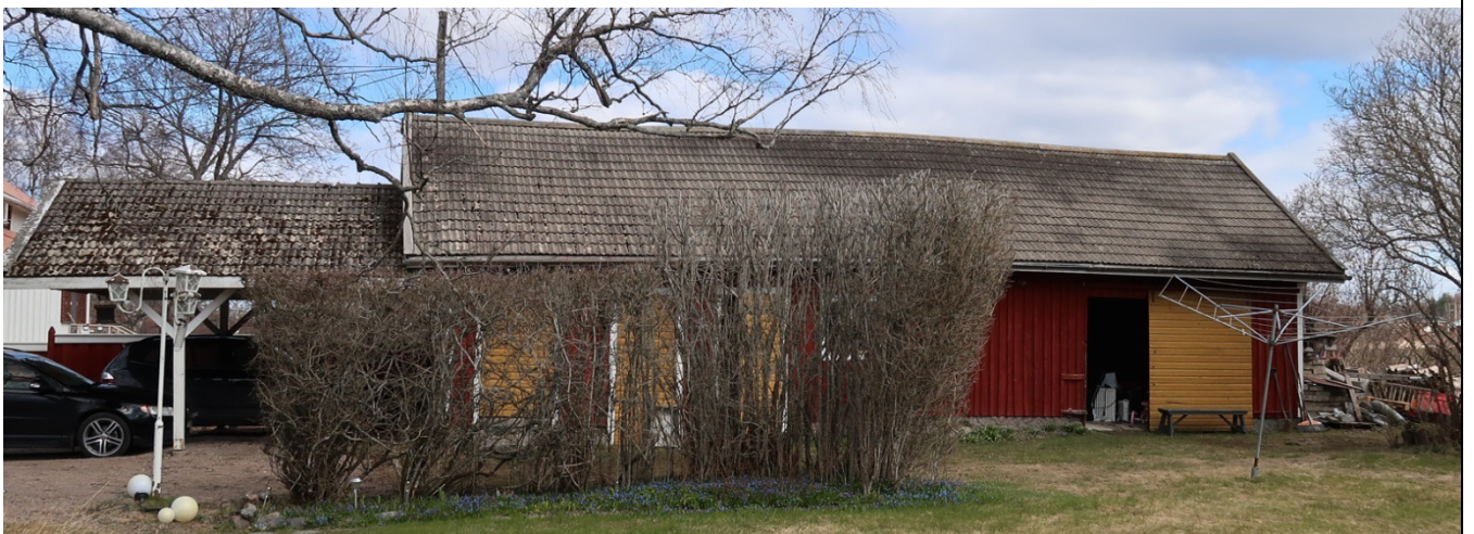
Gårdsbyggnaden består av en äldre del och en carport i gaveln.
