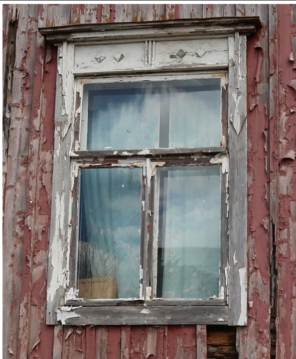
Fönster på södra gaveln.
