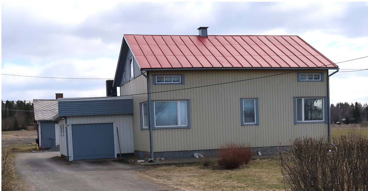
Fasad mot Bangårdsvägen i väst-nordväst.
