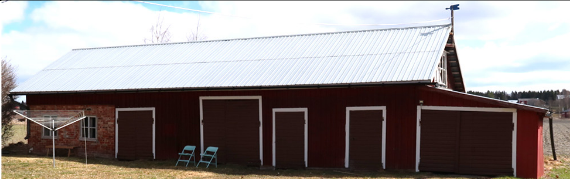
Gårdsbyggnad i östra delen av gårdsplanen.
