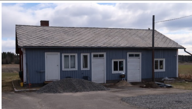
Gårdsbyggnaden sedd från gårdssidan
