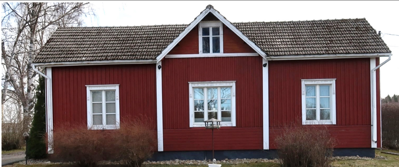
Fasad mot stationsgårdsvägen i väst-nordväst.
