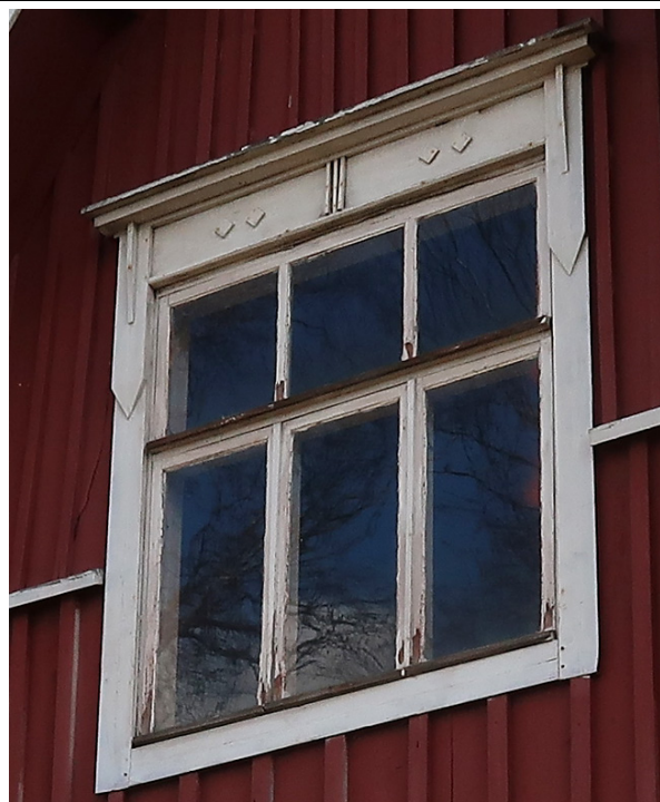
Fönster på tvärgaveln på västra långsidan.
