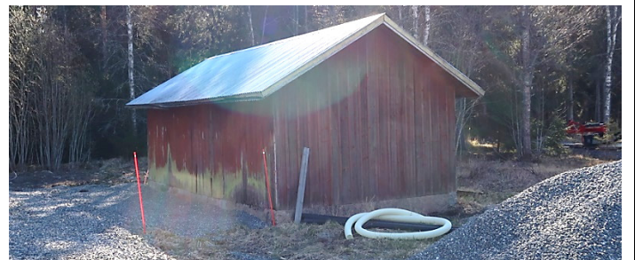
Gårdsbyggnaden från nordväst.
