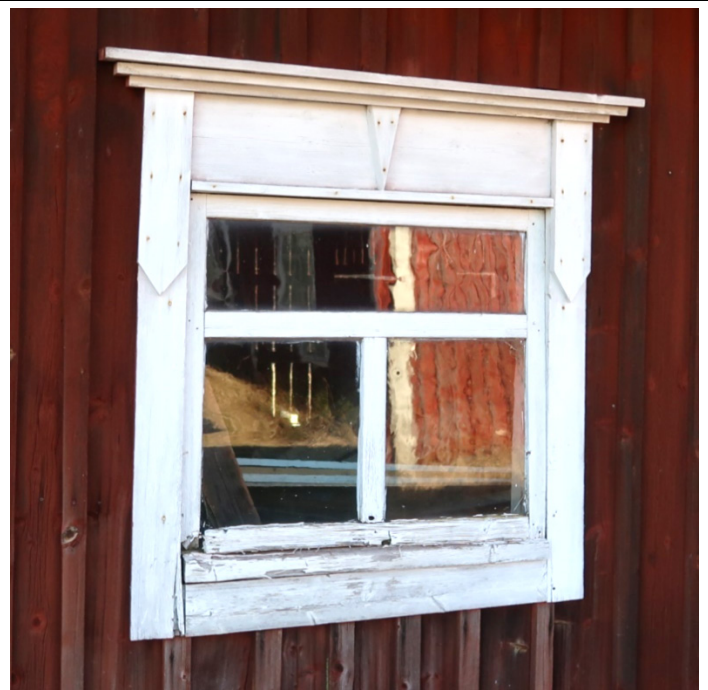
Fönster med dekorativa foderbräden på den avlånga gårdsbyggnaden.
