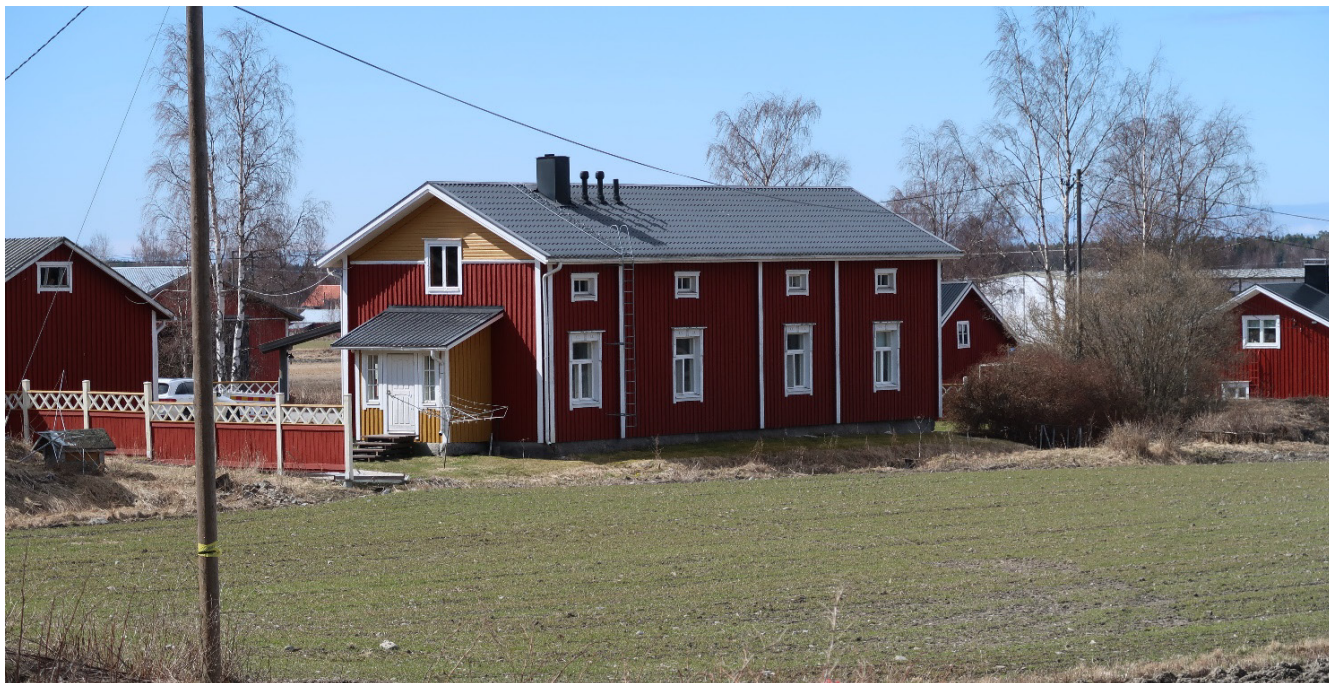
Gårdsområdet sett från Östanåkersvägen i nordost.
