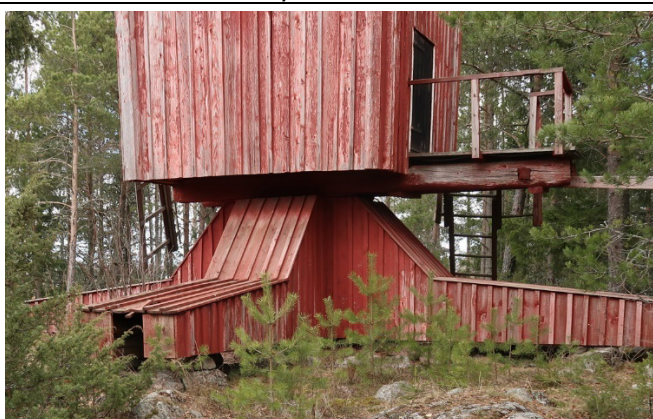
Detaljer på väderkvarnens fundament och nedre del.
