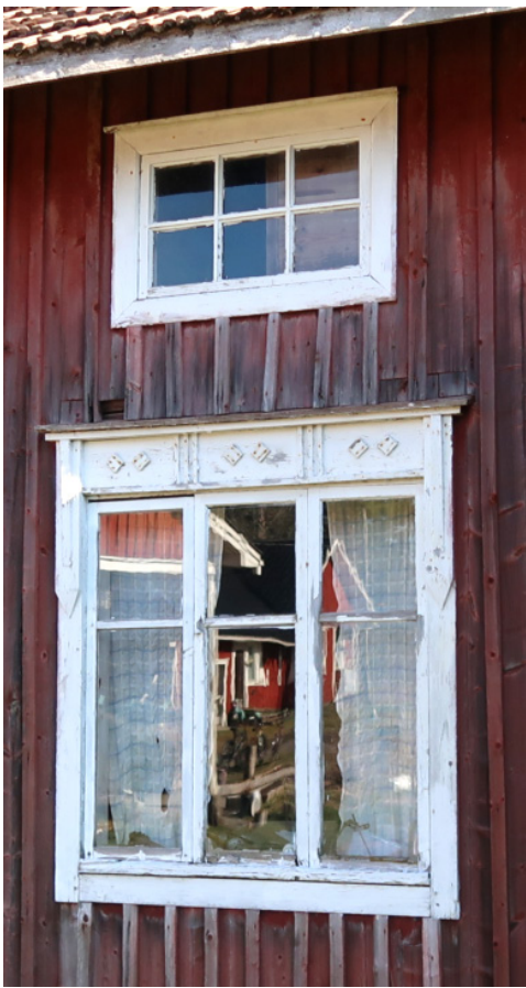
Fönster på södra långsidan.
