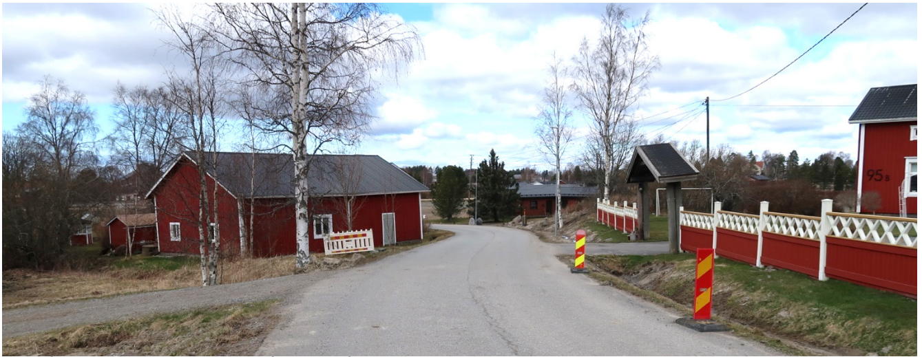
Vy från Stationsvägen mot gårdsområdet.
