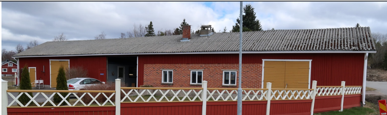
Gårdsbyggnaden sedd från gården i väster.
