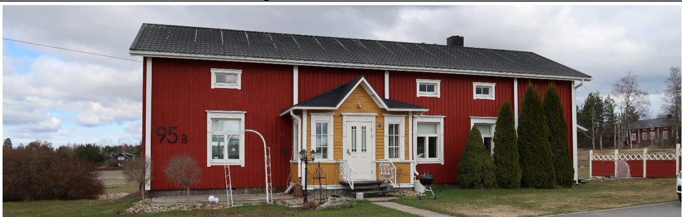
Fasad mot Stationsvägen i söder.
