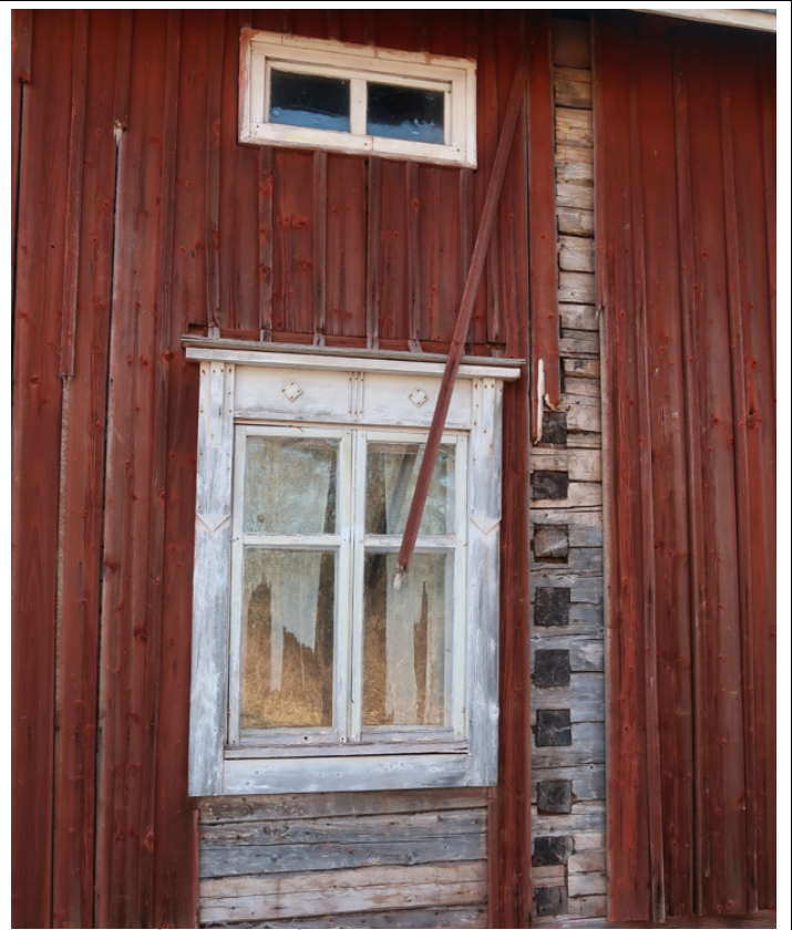
Fönster på västra långsidan.
