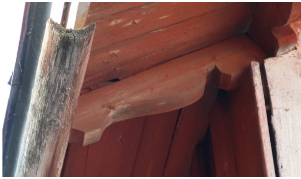
Takrännen i trä och dekorativa avslut på takstolarna.
