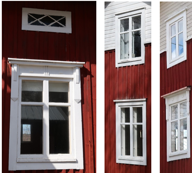
De tvådelade fönstren har mer dekorativa och enkla foderbräden. Vindsfönstret med rombformigt spröjs har enkla foderbräden.
