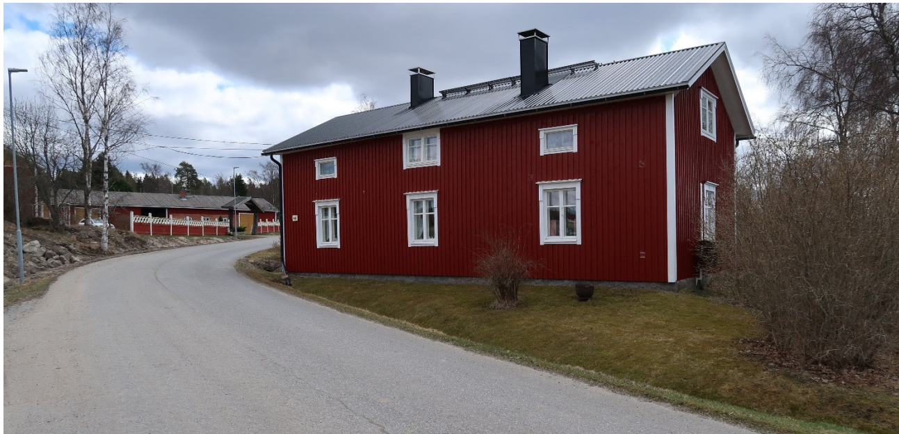
Fasad i riktning mot Stationsvägen i norr.
