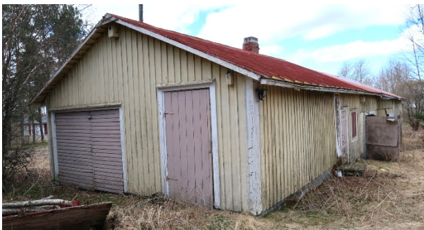
Gårdsbyggnadens gavel mot Östanåkersvägen.
