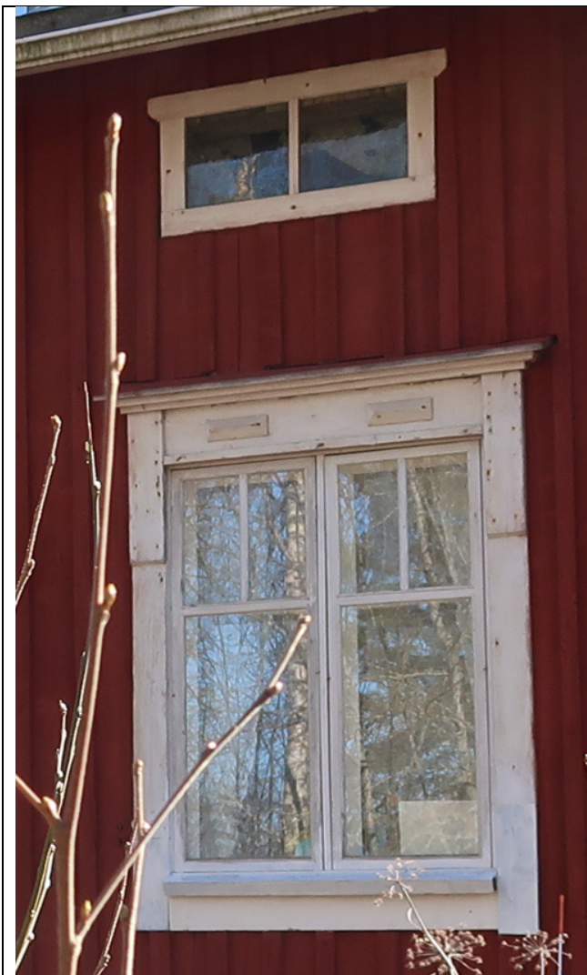
Fönster på västra sidan.
