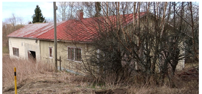
Gårdsbyggnad från sydost.
