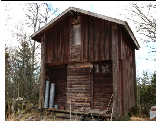
Träbäklädd bod med timmerkonstruktion. Avlång, träbäklädd gårdsbyggnad i östra delen av gårdsområdet.
