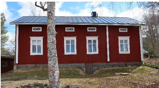
Fasad mot Östanåkersvägen i väster.
