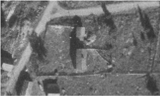
I mitten av 1900-talet fanns det byggnader på byggplatsen. Utdrag ur en flygbild från 1951 (Historiska flygbilder ©LMV).
