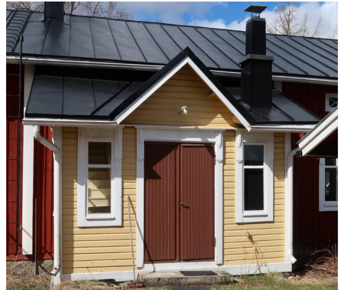
Den symmetriska farstukvisten har dörrar i fingerpanel och en skorsten på taket.
