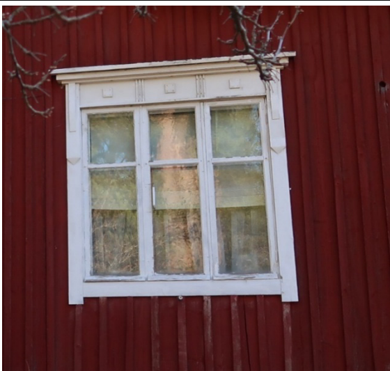
Fönster på västra sidan.
