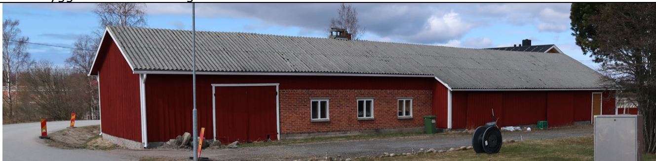
Gårdsbyggnaden sedd från Stationsvägen i öster.
