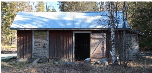
Gårdsbyggnaden från söder.
