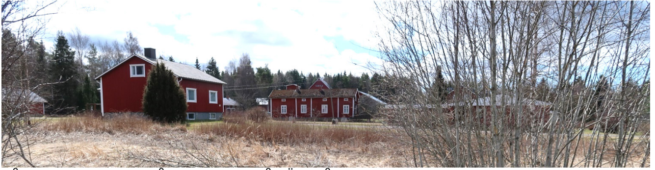
Gårdskretsen i mitten på bilden, sedd från Östanåkersvägen i norr.
