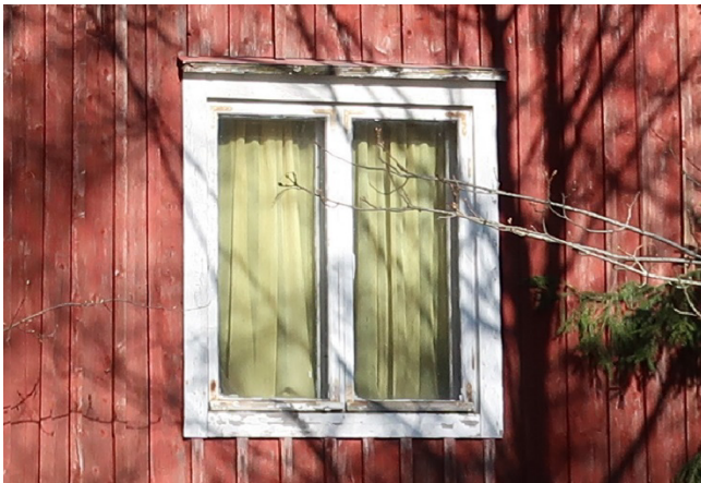
Tvådelade fönster och enkla foderbräden.
