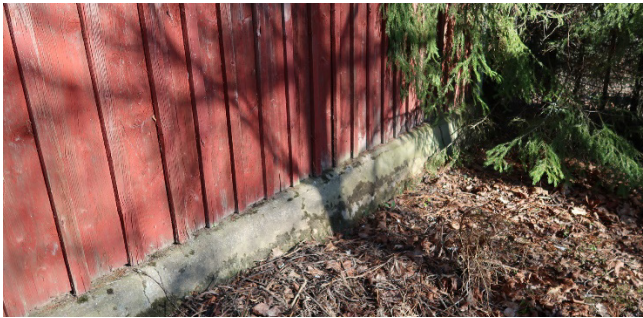
Stenfoten är klädd med betong.
