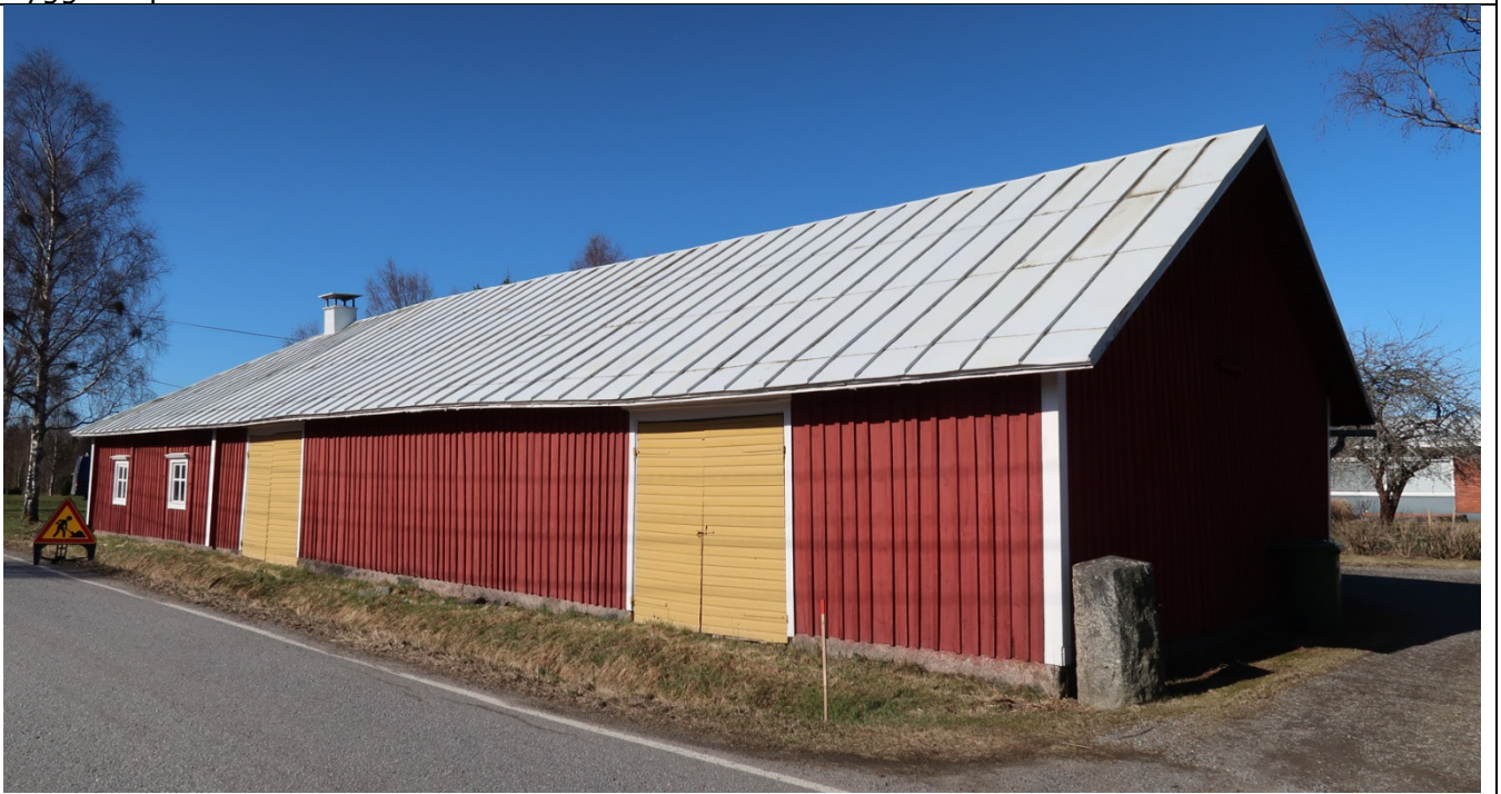
Gårdsbyggnaden från nordost.
