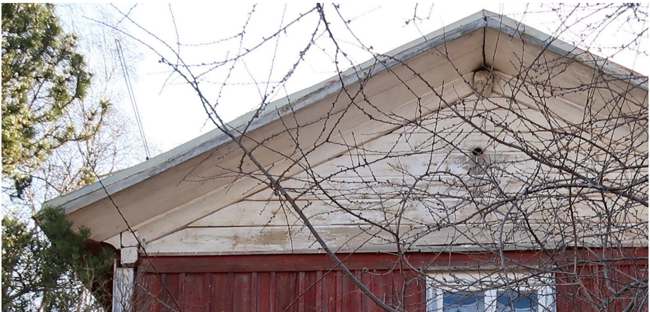
Takfotspanelen och listen är profilerade.
