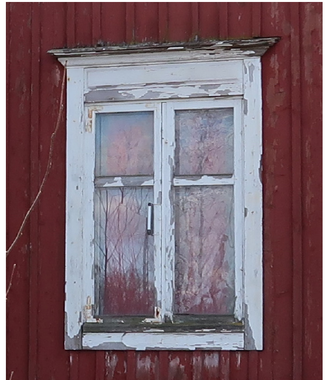
Fönsterramarna har höga överstycken.
