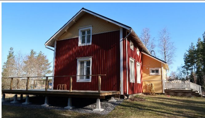
Gavel mot söder. Terrassen är under uppbyggnad.
