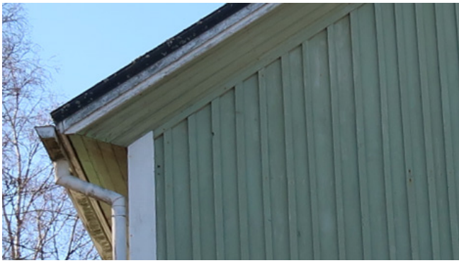
Detalj vid takfoten.
