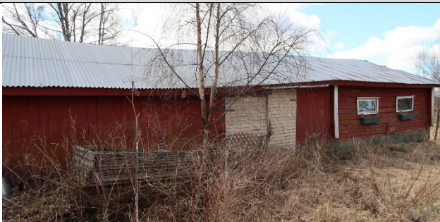
Gårdsbyggnad i riktning med huvudbyggnaden.
