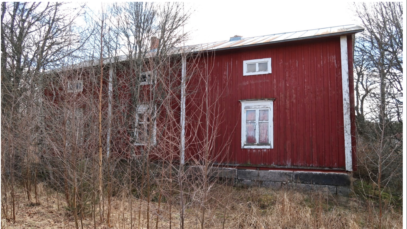
Fasad mot från Östanåkersvägen i norr.
