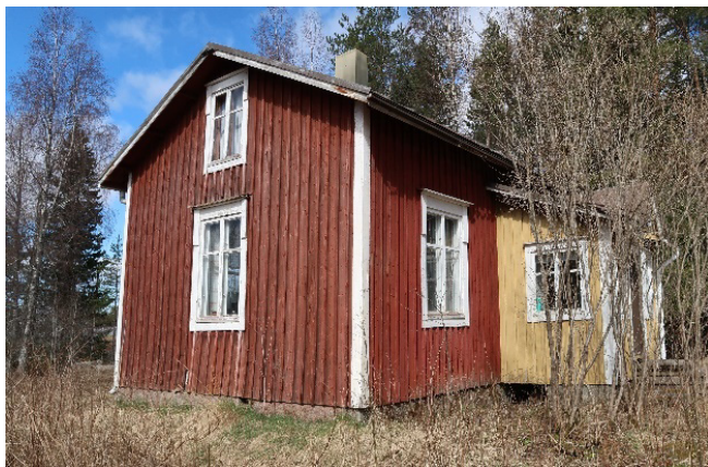
Byggnaden från söder.
