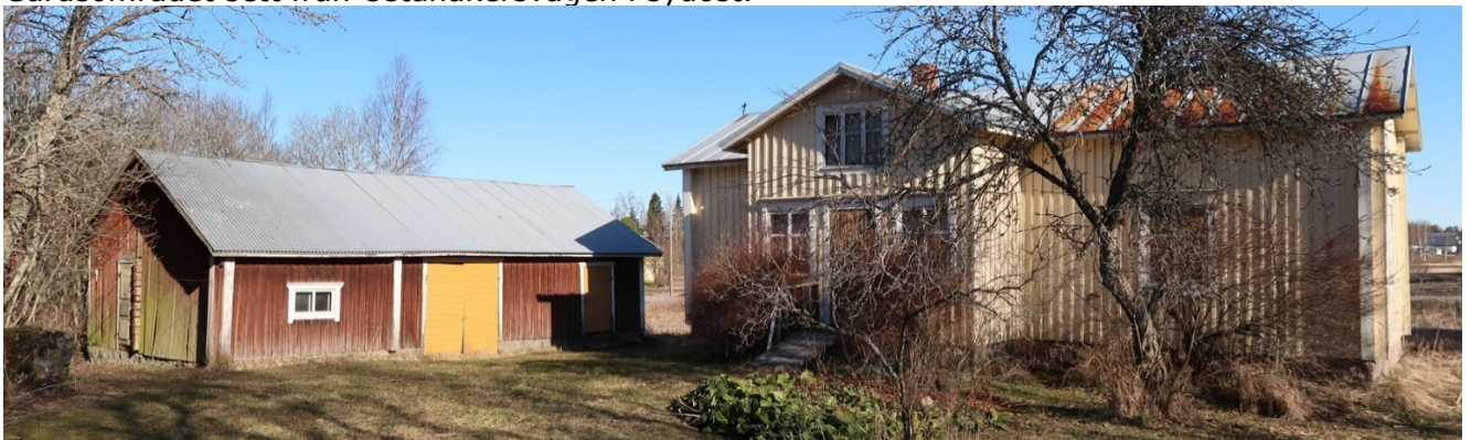
Gårdsområdet sett från Östanåkersvägen i sydost.
