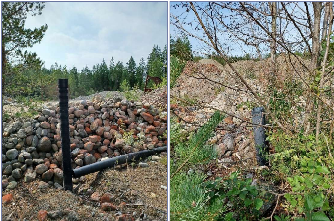
Kuva 19. Maa-ainesten oton luvitukseen liittyen Luokankankaan eteläosan alueelle on asennettu viisi pohjavesiputkea. Kuvisa lounaisin ja itäisin.
