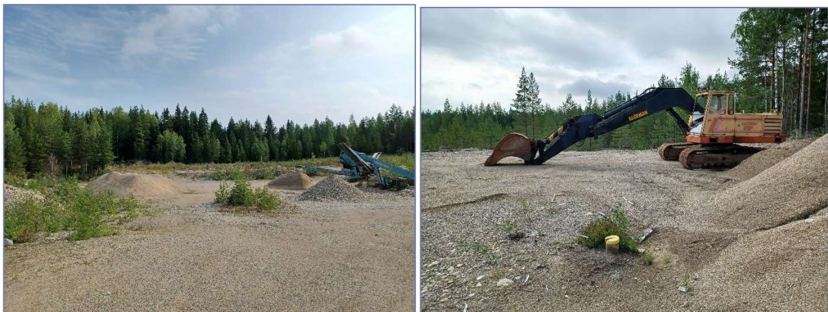
Kuva 18. Luokankankaan pohjavesialueen eteläosaan sijoittuu toiminnassa oleva maa-ainesten ottoalue sekä useita vanhoja ottopaikkoja, joita löytyy myös pohjoispäästä. Oikealla näkyy pohjavesiputki ja kaivinkone.
