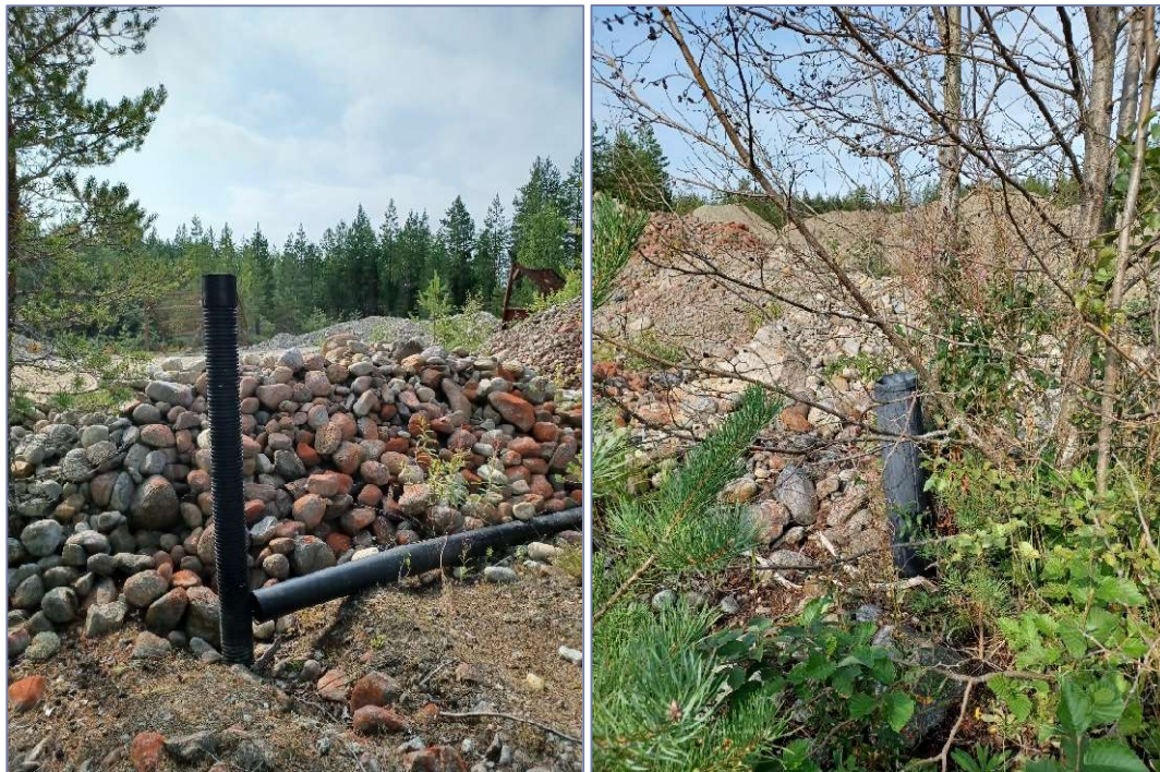
Bild 19. I samband med tillstånd för marktäkt på Luokankangas södra del har fem grundvattenrör installerats. På bilderna i sydväst och öst.
