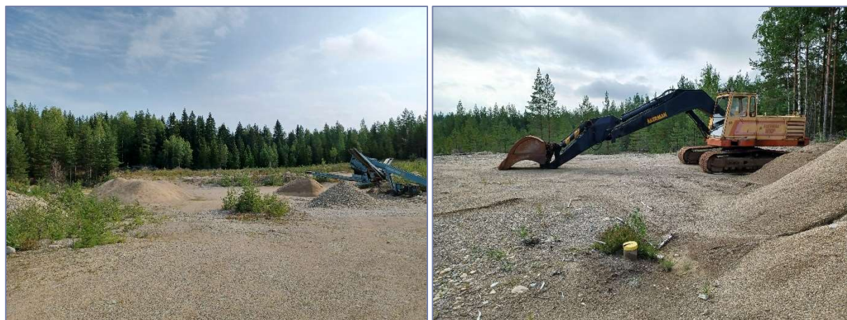
Bild 18. I den södra delen av Luokankangas grundvattenområde finns ett operativt marktäktssområde och flera gamla utvinningsplatser, dessa finns även i den norra ändan. Till höger syns ett grundvattenrör och en grävmaskin.
